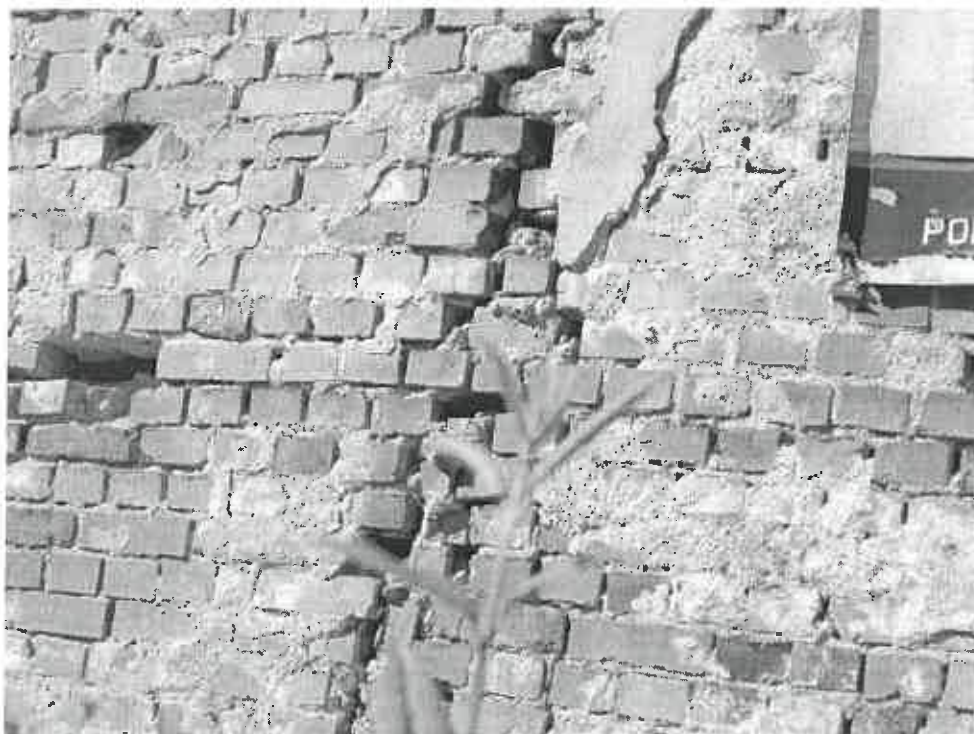
Fot. nr 3. Pionowe rozwarstwienie ściany bocznej - południowej.
