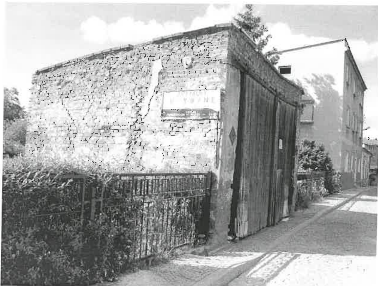
Fot. nr 1. Widok od strony frontowej - południowej.
