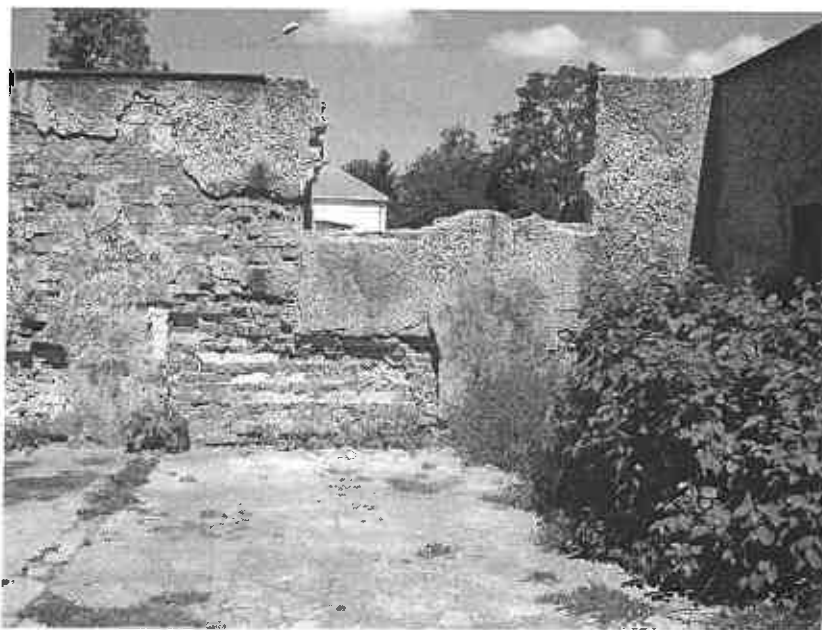
Fot. nr 9 widok muru ogrodzeniowego od strony placu manewrowego.
