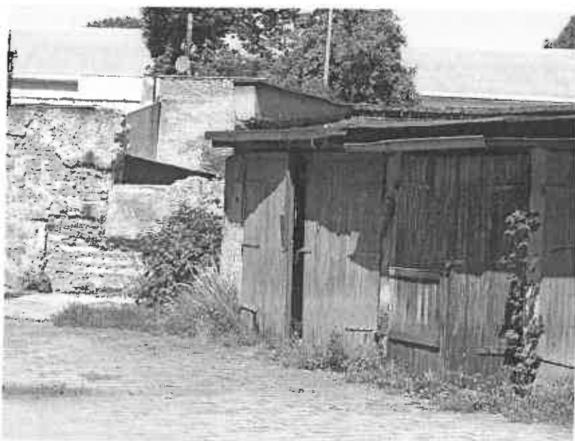
Fot. nr 1 widoczny garaż z fragmentem muru ogrodzeniowego.
