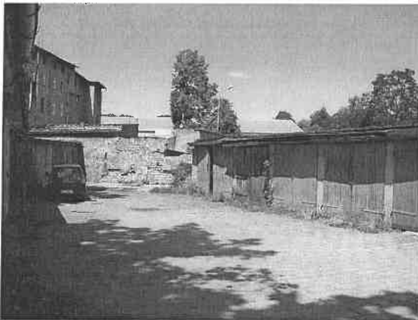
Fot. nr 3 w tle widoczny fragment muru do rozebrania.
