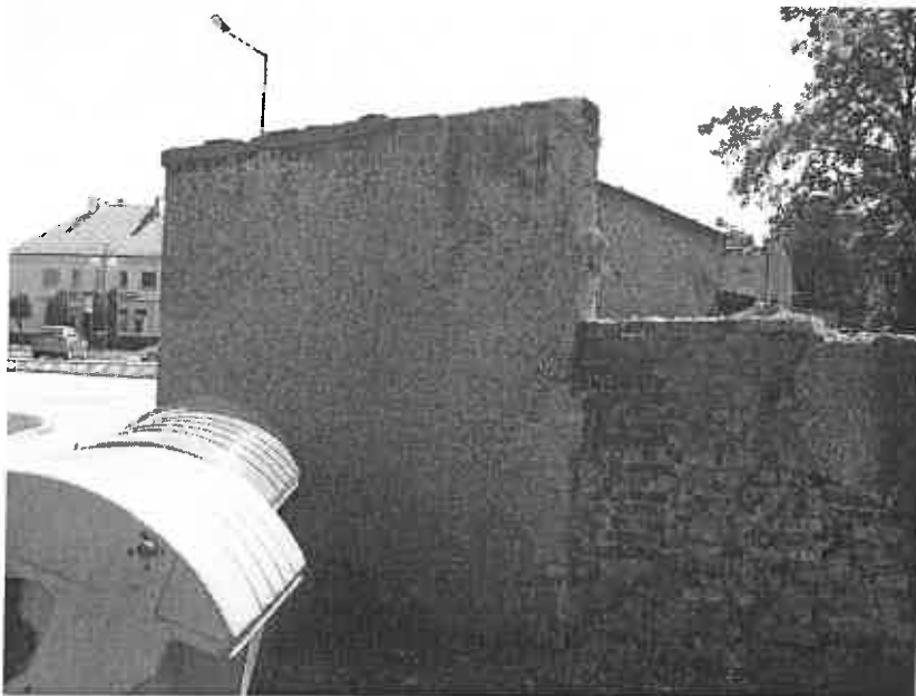
Fot. nr 9 widok muru ogrodzeniowego od strony zewnętrznej (dz nr 690/4).
