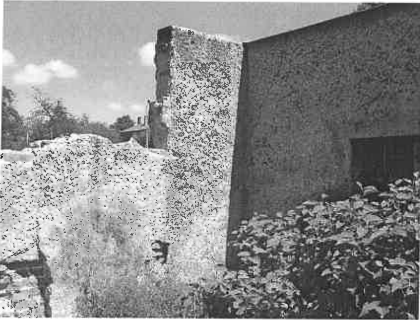
Fot. nr 10 widok muru ogrodzeniowego od strony placu manewrowego.
