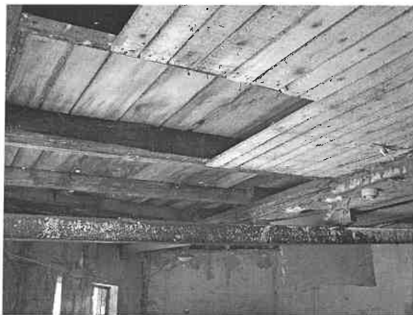
Fot. nr 7 podciąg stalowy podpierający płatów konstrukcji dachowej.
